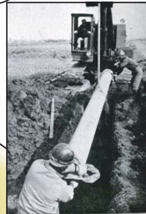
土地改良事業のパイプライン工事
