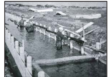
土地改良事業の水路工事
