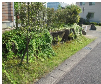
芝張り法面などで緑化する例
