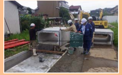
水路築造工事 (東茶屋地区)
