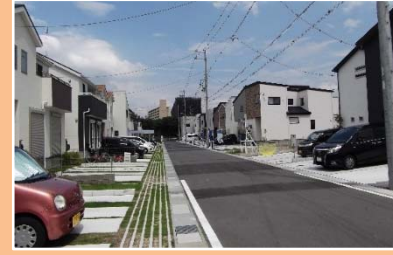
区画道路築造・舗装工事 (川原地区)
