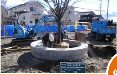
公園築造工事 (大西第二公園)
